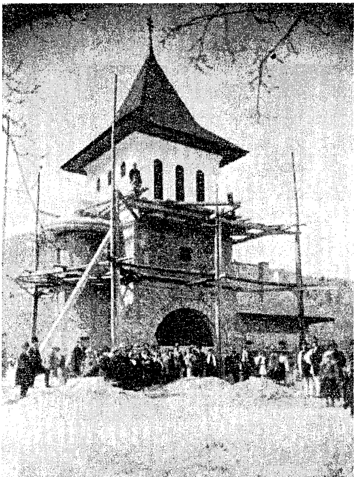
Imagine din timpul reparațiilor făcute la Mănăstirea Brâncoveanu de la Sâmbăta de Sus stareț fiind Părintele Arsenie Boca
